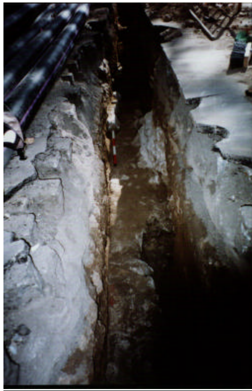
Foto 2. Vista de la rasa 1 amb la muralla a la dreta, U.E. 105, i la claveguera a l'esquerra, U.E. 106.
