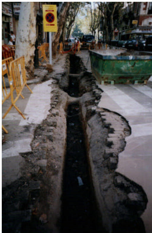
Foto 6. Vista longitudinal en sentit nord-sud de las rasa 2 un cop excavada.
