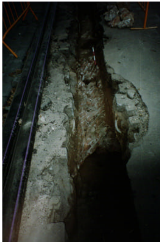
Foto 4. Gran col·lector passant sota la rasa 1.
