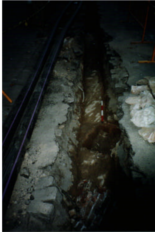
Foto 5. detall de l'imbornal del col·lector, rasa 1.
